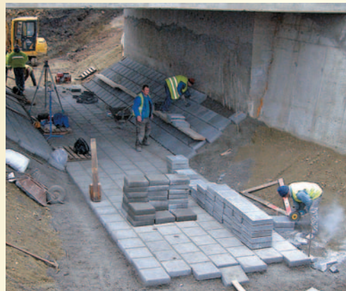
Karcagi-I. csatorna burkolása
