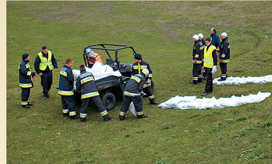
Gyakorlat keretén belül bordás megtámasztás építése a 10.04/3 örjárásban
