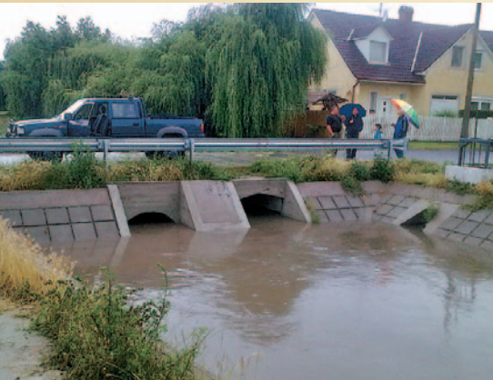
A nagykovácsi fedett szakasz mértékadó terhelés közben
