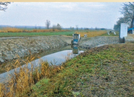
A Kakat-csatorna hosszúhátú műtárgya burkolatának javítása
