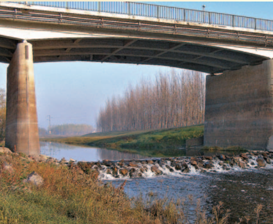
Helyreállított fenékküszöb a Sebestyén körüli híd alatt
