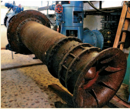
Sajfoki szivattyútelep 1. gép a nagyjavítási munkák előtt
