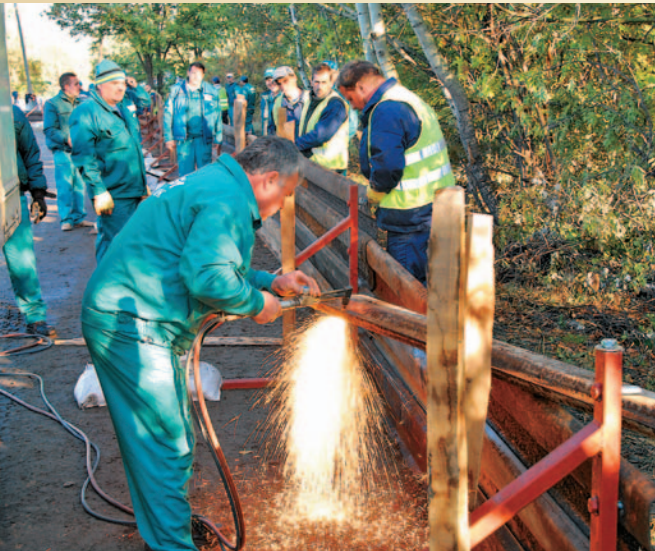
Szádfalépítés a védelmi gyakorlaton
