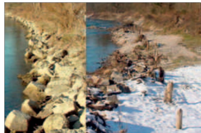
Aufweitung des Gewässerbetts / Uferbrücken (vorher/nachher)
